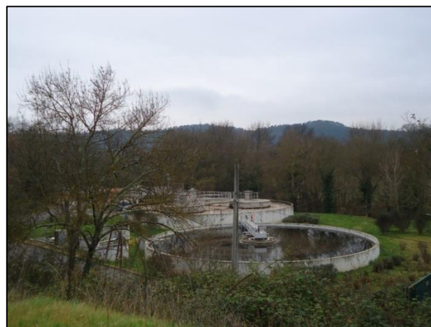
Figure 3 : Station d'épuration de la commune de Le Val (photographie 20/01/2016)
